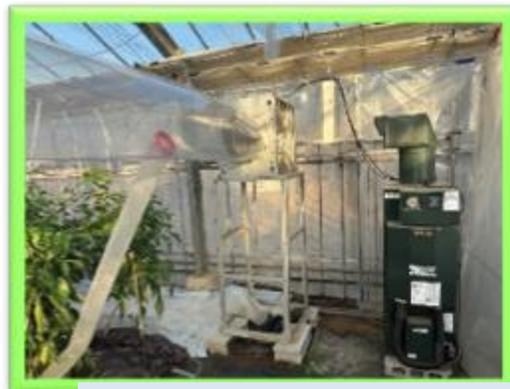
ピーマンに炭酸ガスを送るダクト(左)と炭酸ガス発生装置(右)
